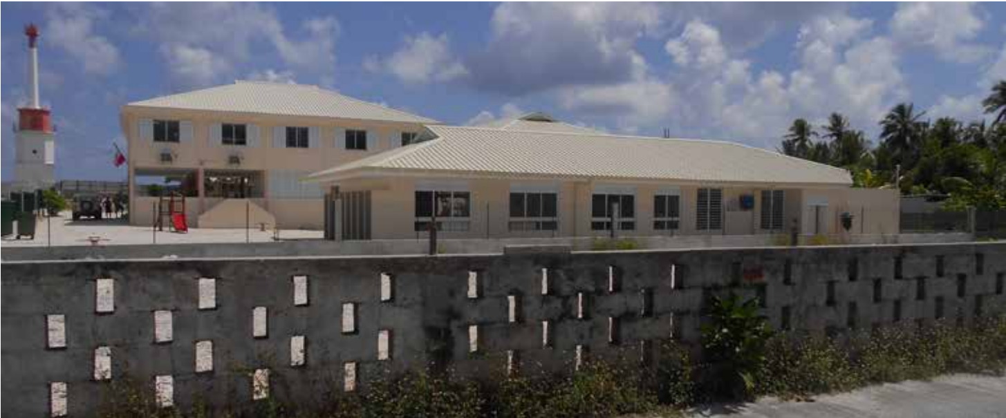
Étape d'avancement du chantier
