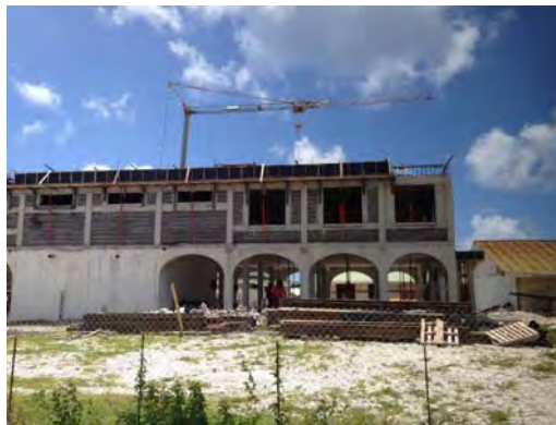
Chantier du CED – Novembre 2013
