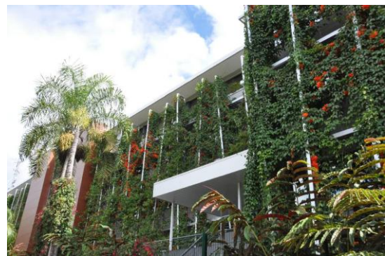
Façade arrière végétalisée contre l'ensoleillement
