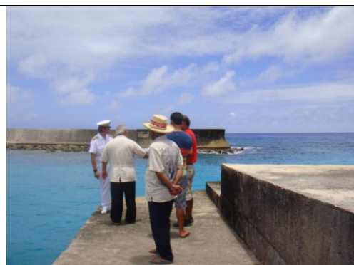
Visite du quai de Moerai
